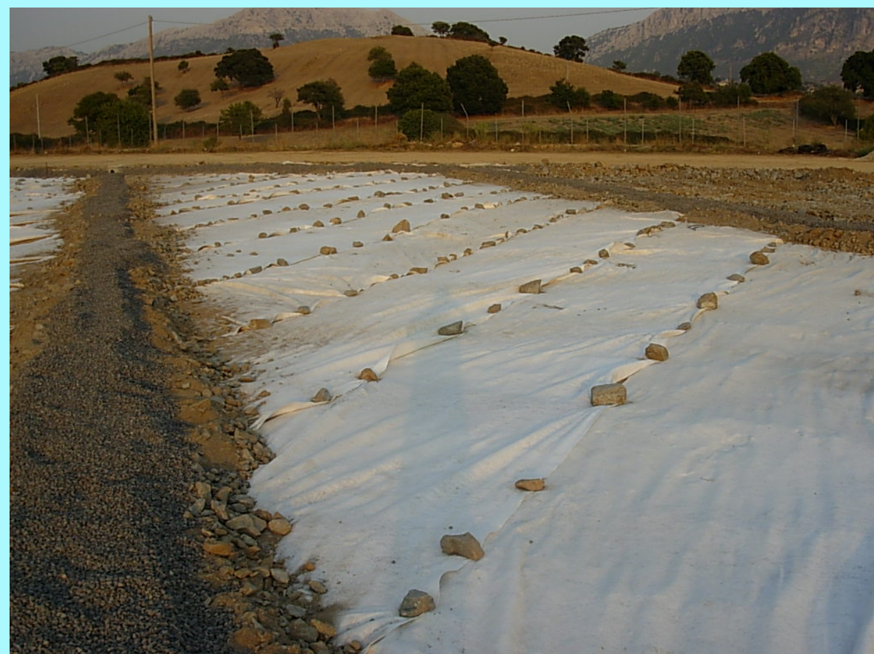
Completamento drenaggio con tessuto non tessuto
