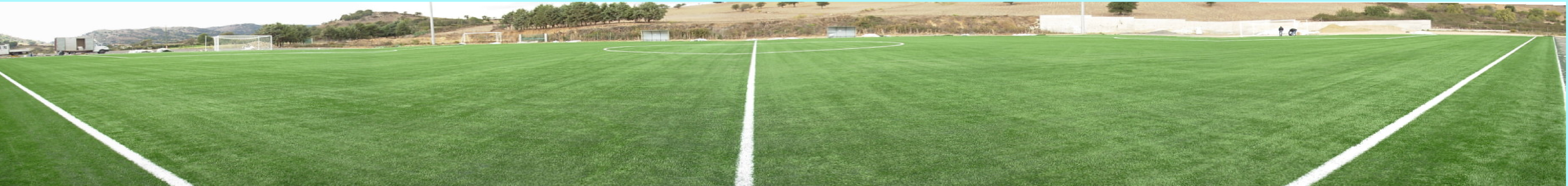
Vista panoramica campo di calcio dopo posa erba sintetica
