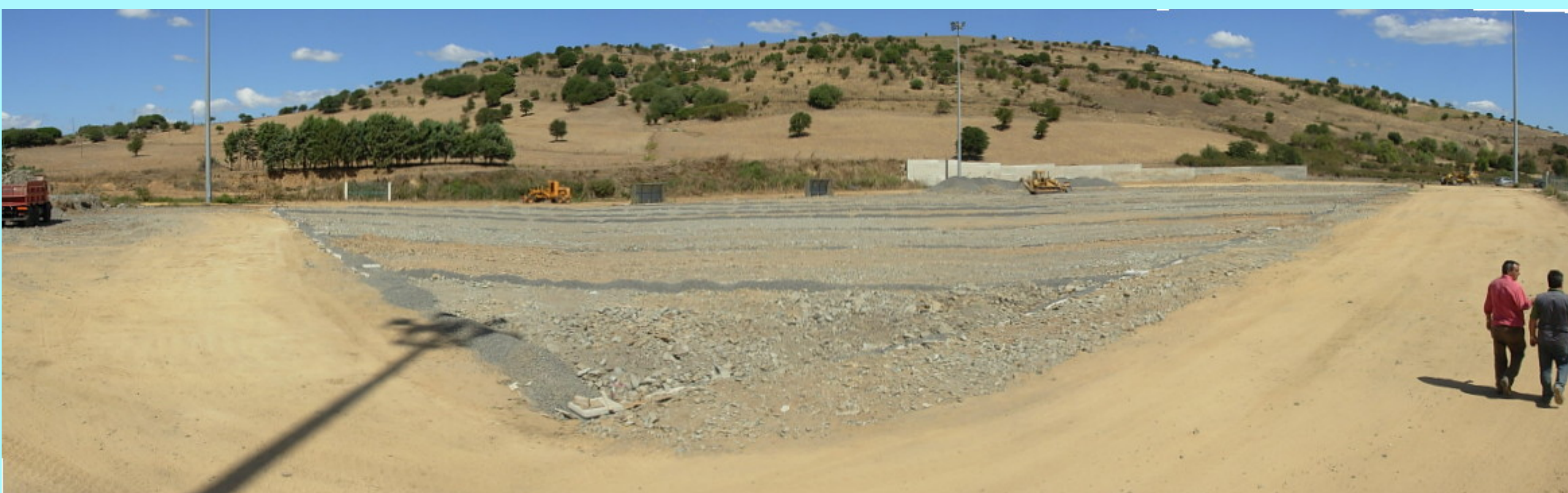
Vista panoramica campo di calcio dopo posa dreni
